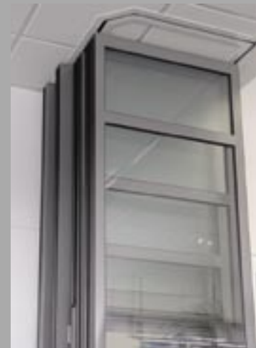
Punto de aparcamiento de los paneles / Estação de painéis
